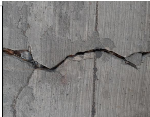
Fotografía 9 y 10: Vista de parte del tramo pavimentado donde se observa falla estructural en el pavimento hidráulico, de entre 5-25 mm.
